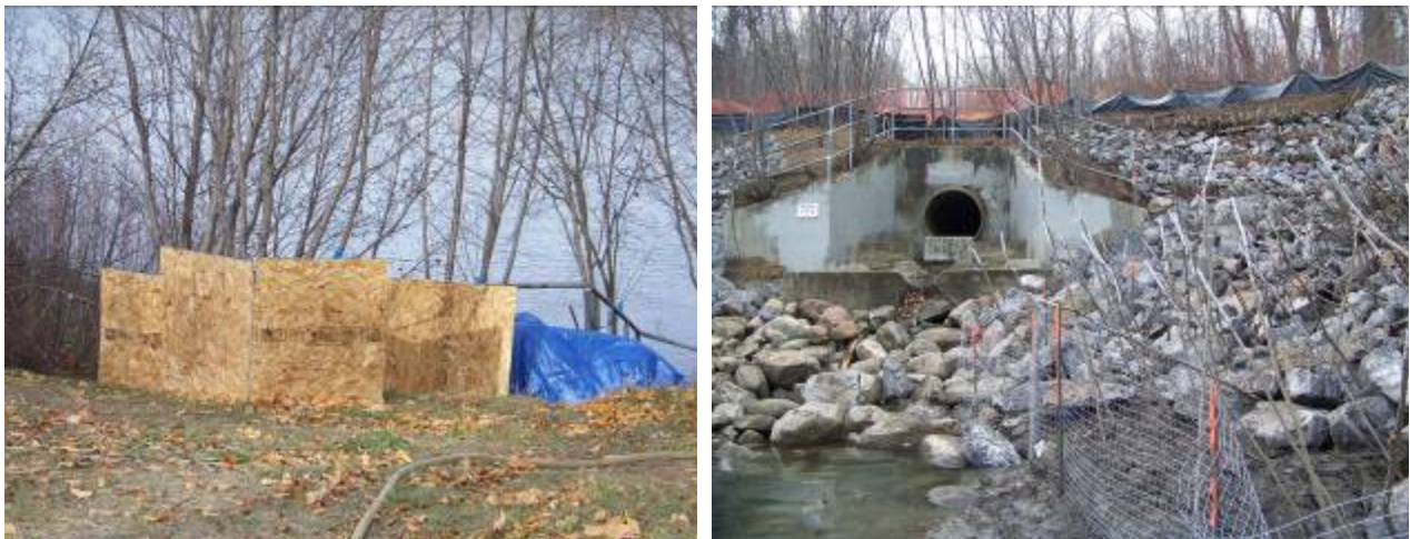
Figure N.1: Tree protection and Sedimentation Control, Outfall 101 Edmonton Alberta 1
