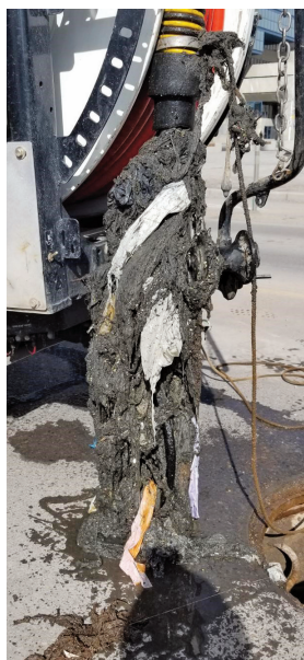
從污水管道中清除的無法沖走的堵塞物。
